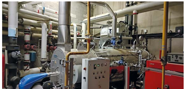
Une machine à vapeur est utilisée pour chauffer les moules pour le pressage de disques.
